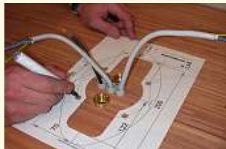
Anschlußtechnik freistehendes Objekt
